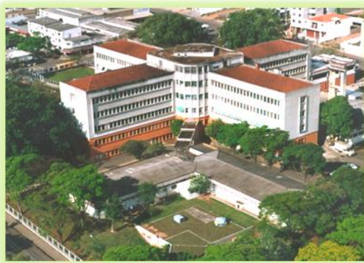
Figura 1: Departamento de Atenção à Saúde em Alta Complexidade - HCI
